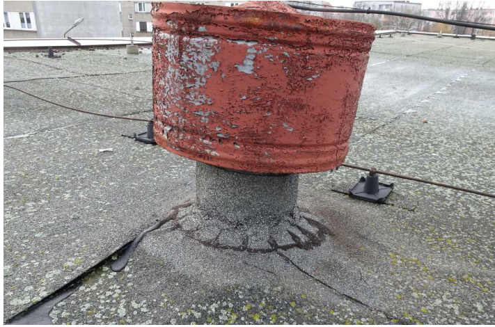
Zużyta powłoka malarska na kominach stalowych
