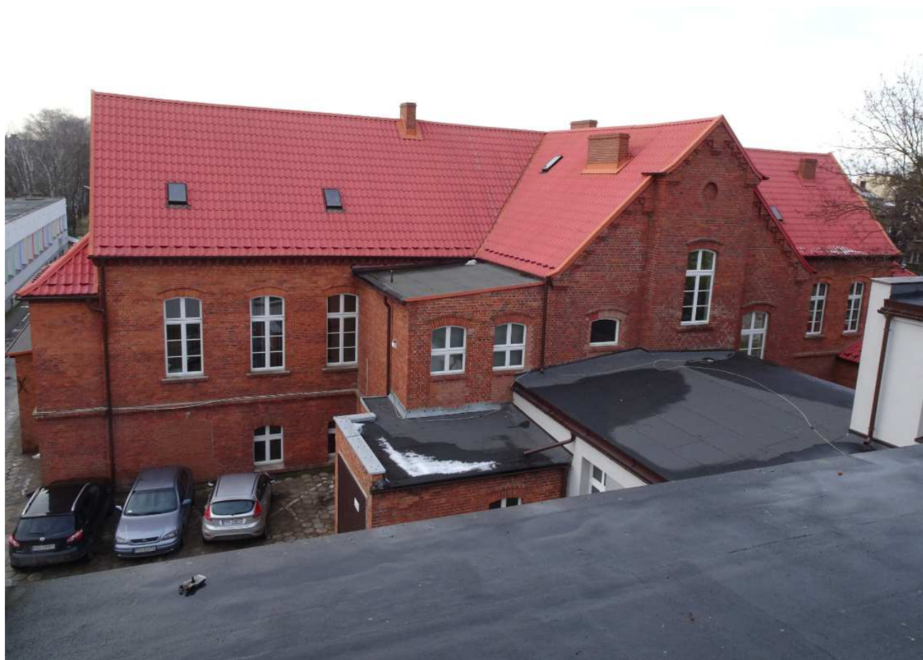
Ogólny widok na dach z blachodachówki
