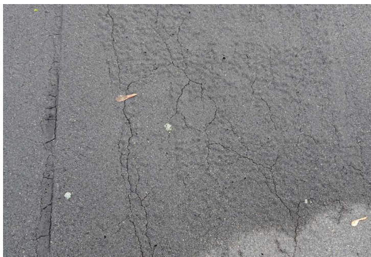
Pokrycie dachowe z papy w złym stanie technicznym
